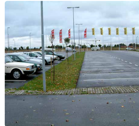
Dagvattnet från parkeringsplatsen rinner till en infiltrationsyta (svackdike) istället för till brunnar. Resultatet blir utjämning av flödet och rening av dagvattnet. Fotot är taget i Svågertorp.
