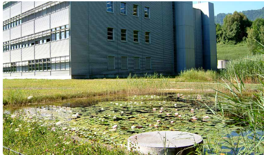
Dagvattendamm vid en industribyggnad i Zürich.
