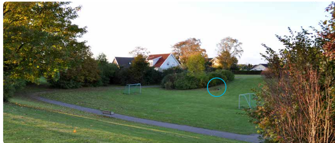
En park i Lomma används både som översvämningsyta vid stora regn och som fotbollsplan. Bräddavlopp från ledning till översvämningsyta är inringad.
