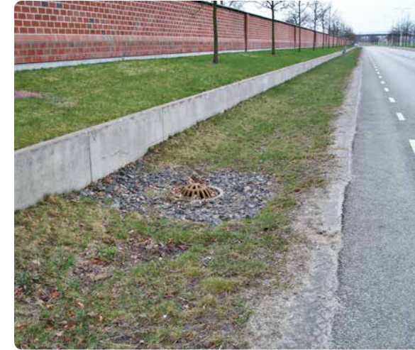
Ett dike där dagvatten från vägen fördröjs och renas istället för att rinna till dagvattenbrunnar i vägen. Diket finns i Malmö.
